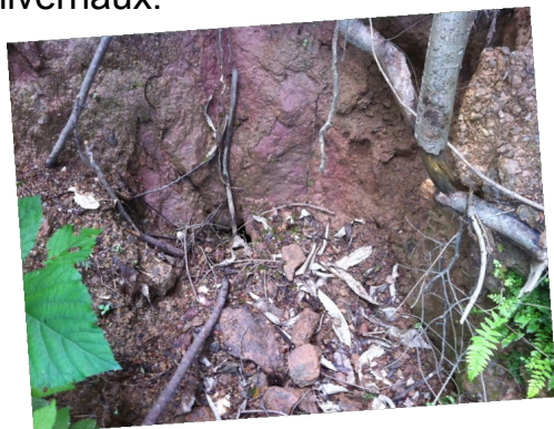
Entrée de la cavité obstruée par l'éboulement
