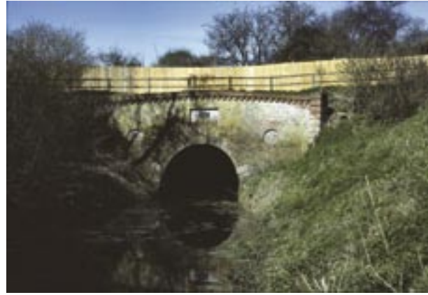
Entrée du tunnel de Greywell, Grande Bretagne.
